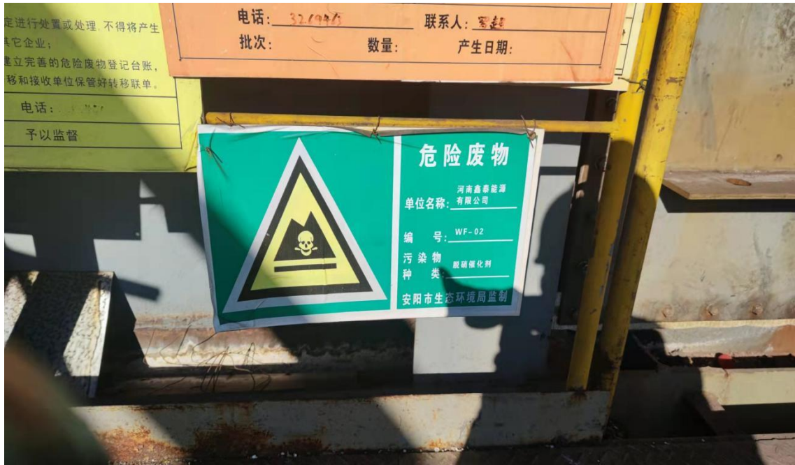
烟气脱硝催化剂生产设施现状
